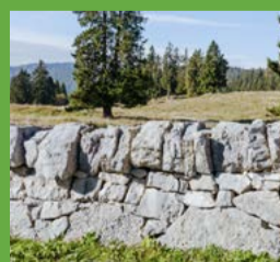
Murs de pierres sèches
